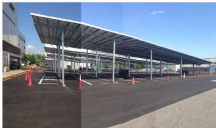
兵庫県食品工場駐車場 駐車台数100台 250kW 食品工場の従来食用駐車場にカーポートタイプを設置しました。
