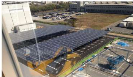
第一工区完成 第二工区建方 現場写真 工事中の駐車可能台数を減らさないために工区分けを行いながらの施工も可能です。
